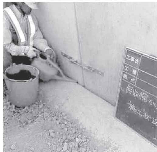
◆基礎コンクリート溝部◆
